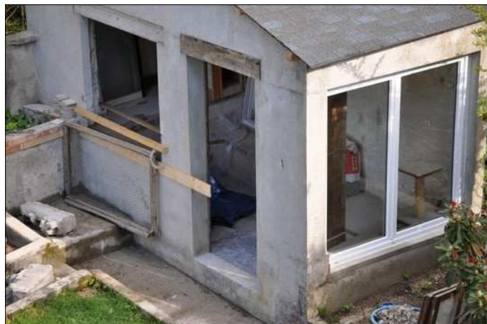
Travaux de transformation
