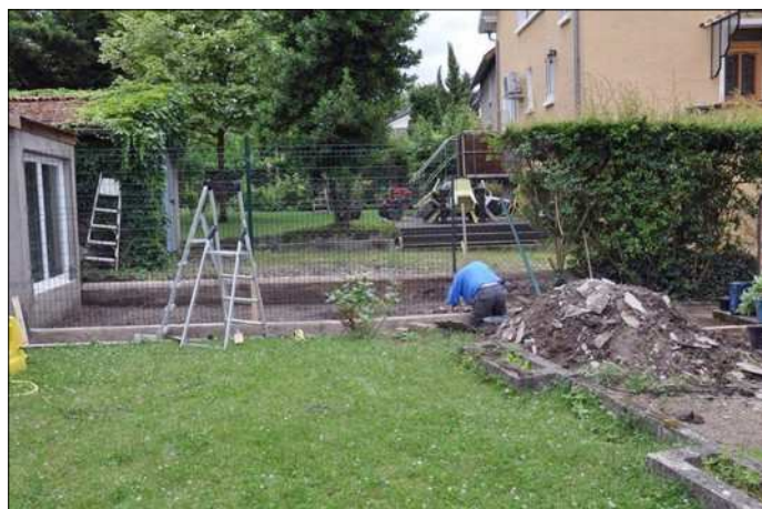
Travaux pour l'adjonction d'un enclos grillagé
